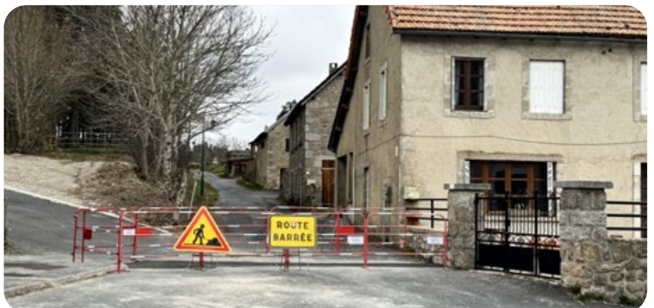
Réfection grille à St Sauveur de Peyre
