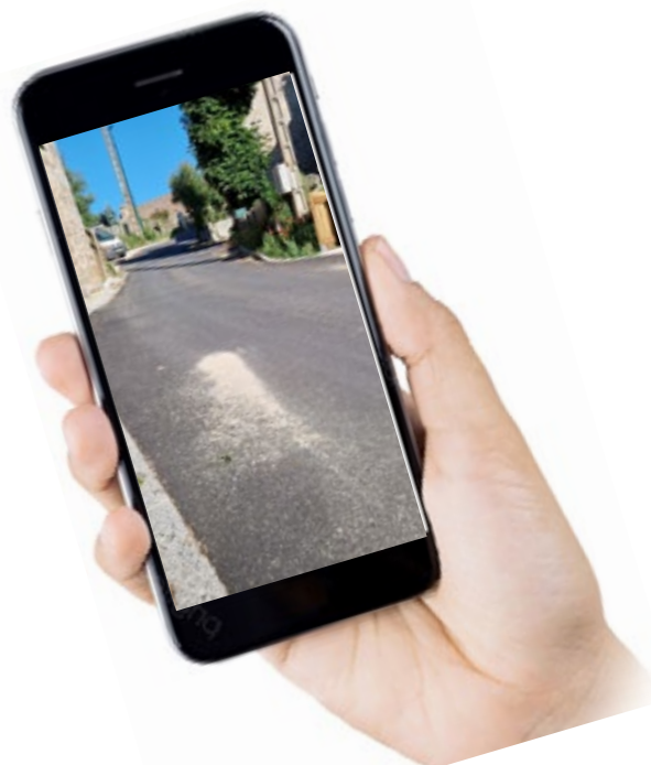
Élargissement de voie à La Pignède
