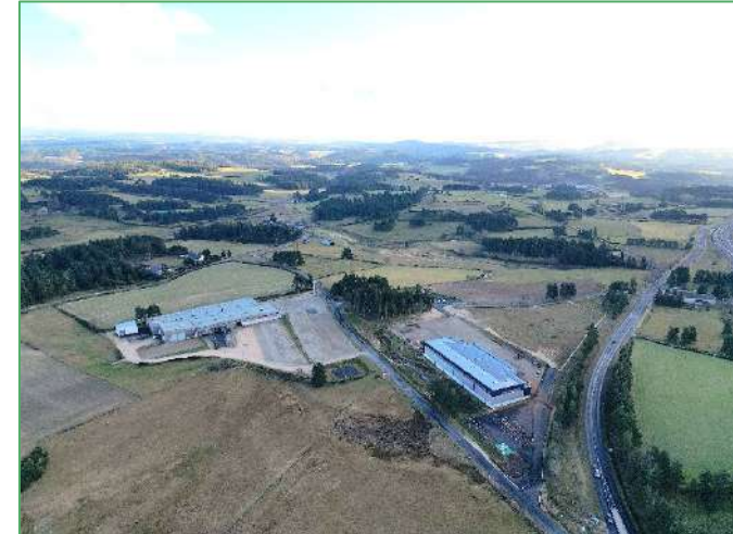
Vue aérienne de la ZAE Aumont Sud - © Campus
