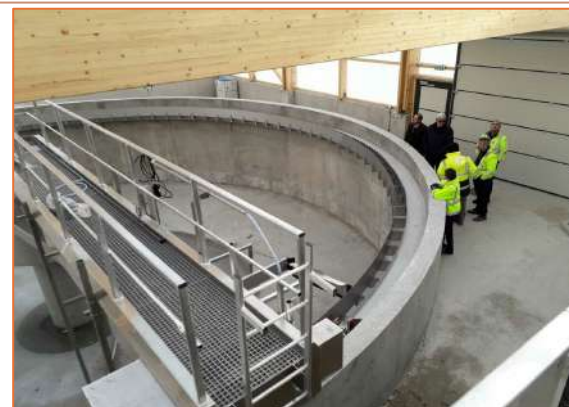
Station d'épuration de Peyre en Aubrac (Aumont-Aubrac) – © SDEE Lozère
