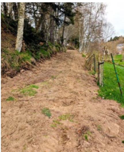
Élargissement d'un chemin à Rimeizenc
