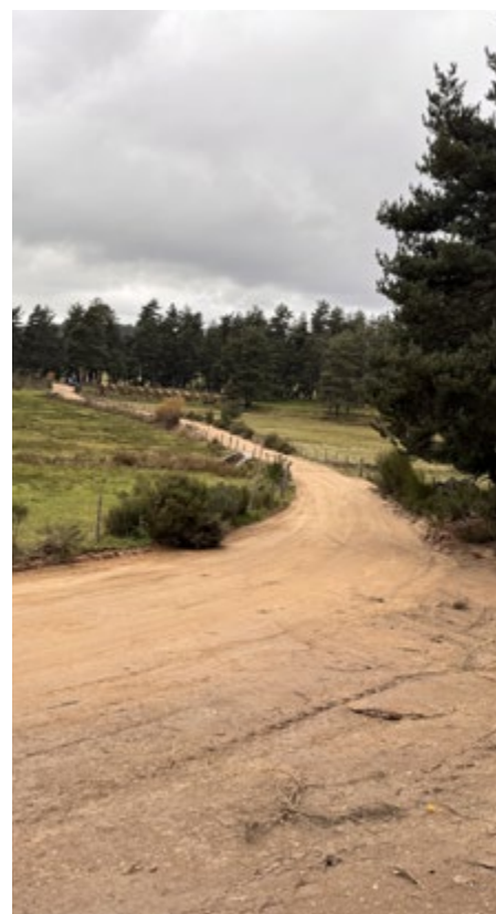
Travaux sur les chemins ruraux
