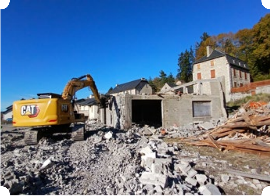
Démolition hangar quartier de la gare d'Aumont
