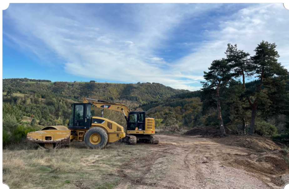
Réfection chemin Prat-Peyreviolles
