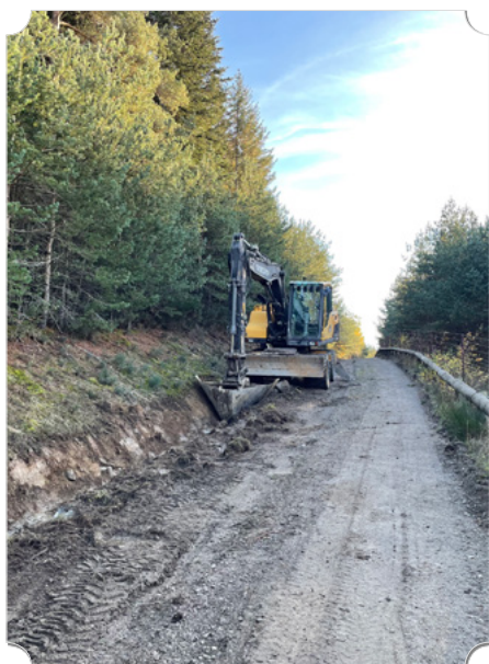
Réfection chemin à proximité des Andes
