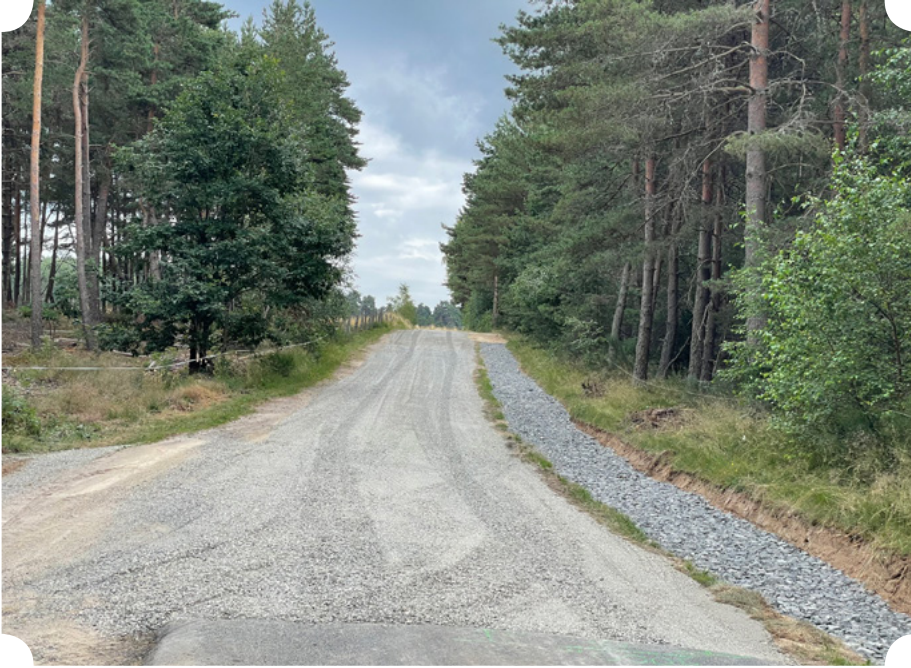
Travaux voie communale du Démenty
