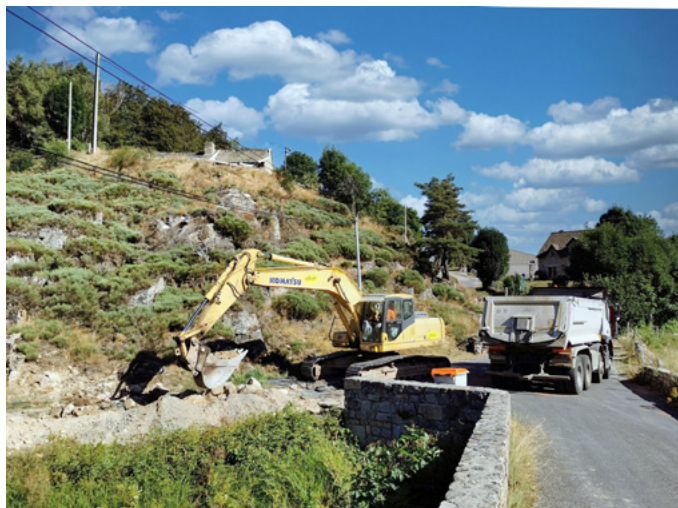
Travaux pour enfouissement des réseaux secs au Chambon
