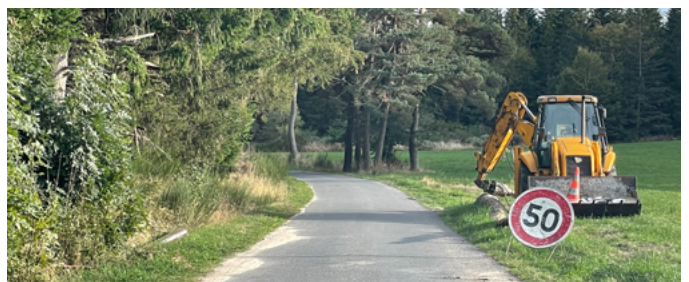
Déploiement fibre vers Combechave et Chapchinies
