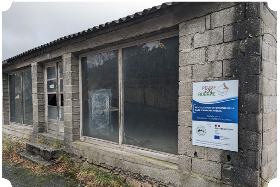
Démolition ancien entrepôt du quartier de la gare d'Aumont
