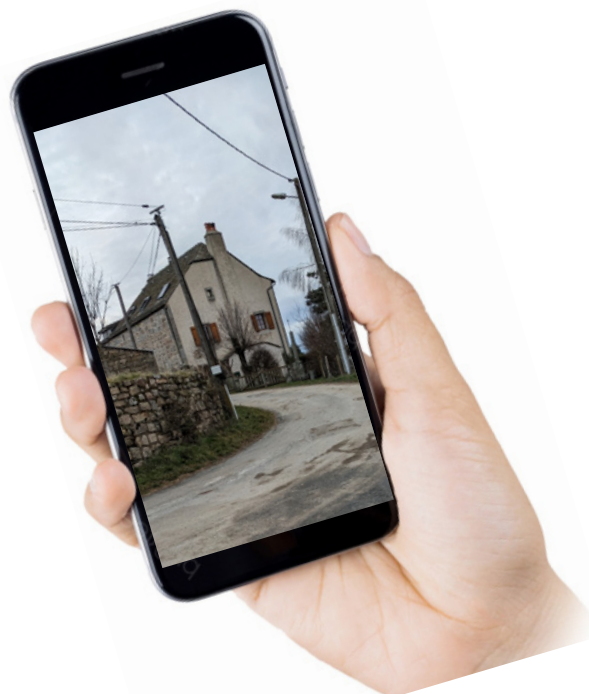
Réfection voie communale Chancelades
