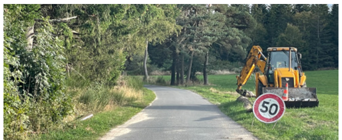
Déploiement fibre vers Combechave et Chapchinies
