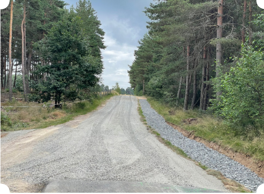
Travaux voie communale du Démenty
