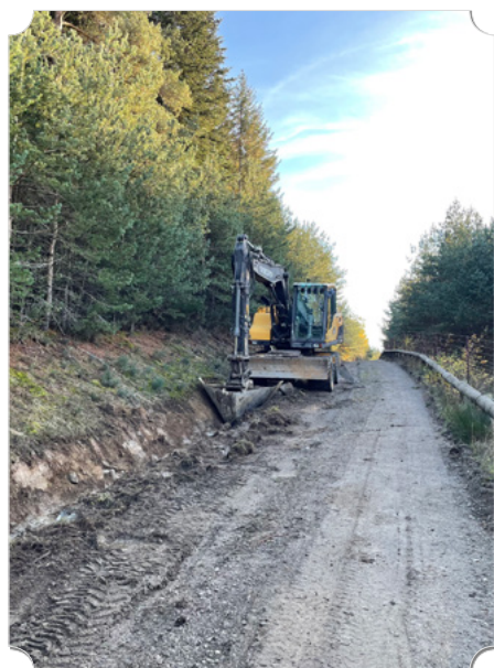
Réfection chemin à proximité des Andes
