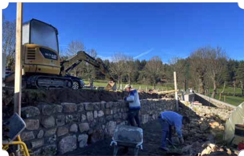
Réfection mur à Fontanes
