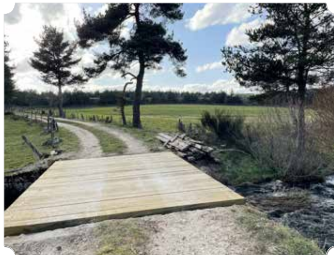
Réfection pont à proximité de Couffinet
