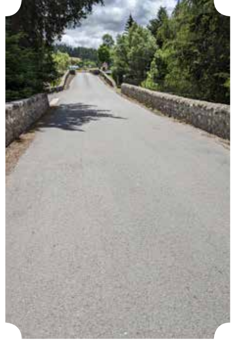
Réfection traversée Javols
