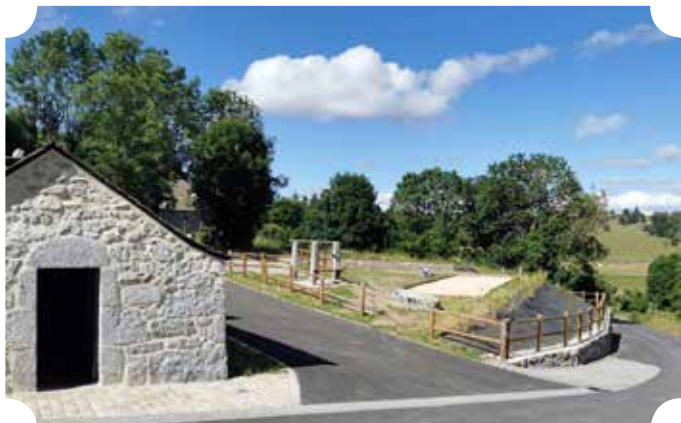
Fin des travaux aux Salhens
