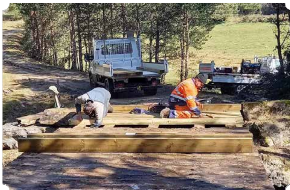
Travaux à proximité de Couffinet
