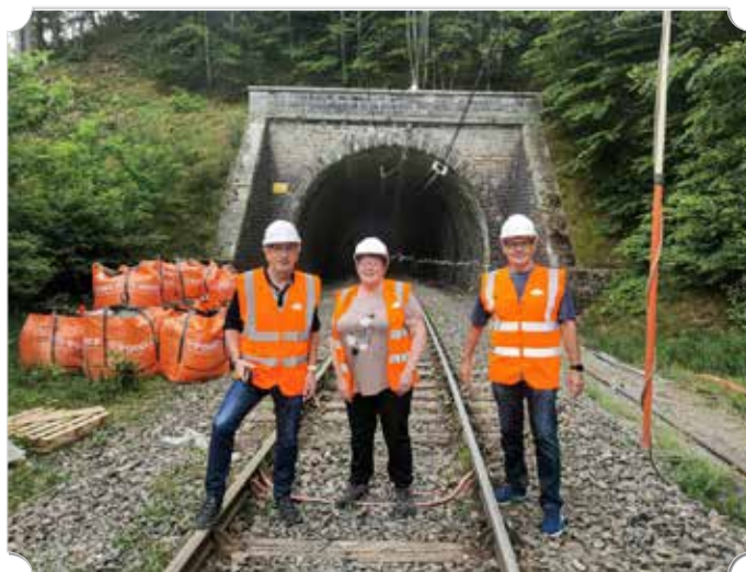
Visite tunnel de l'Estoura
