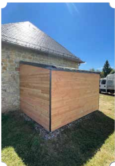
Réfection du local de jeux à l'école de St Sauveur
