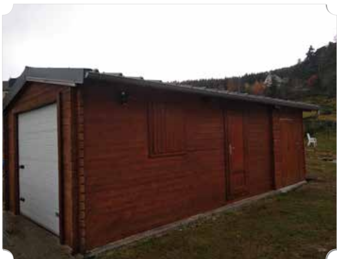
Abri de jardin réalisé à Ste Colombe de Peyre
