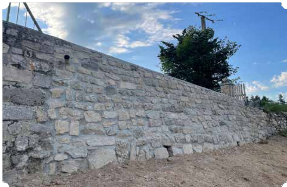
Réfection d'un mur au bourg principal de St Sauveur
