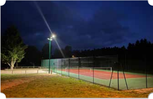
Nouvel éclairage court de tennis à St Sauveur
