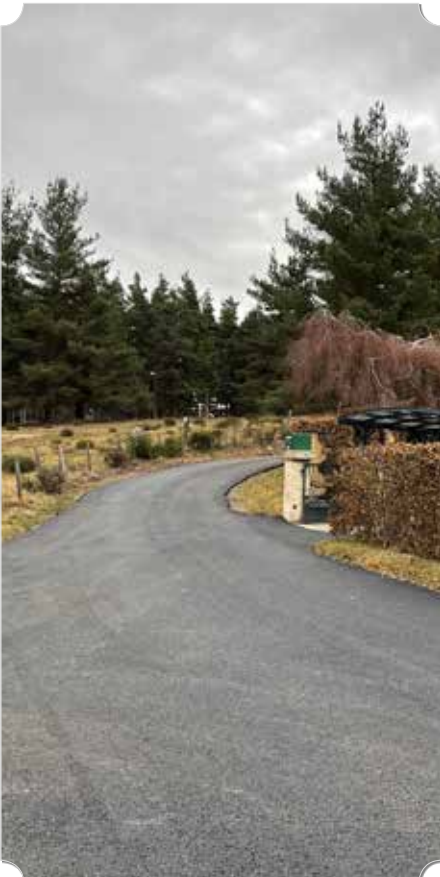
Réfection voirie PN109
