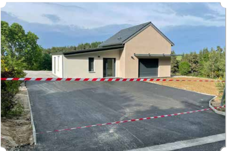
Fin des travaux à la maison de la chasse et des associations de Saint-Sauveur
